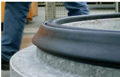
Povezava elementov z izoblikovanim nastavkom za namestitve ohlapnega tesnila ter obročem za prenos obremenitve
